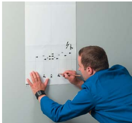
1. Příprava montáže pomocí montážní šablony
